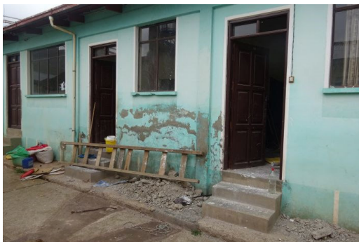
Karipuyo: Renovierung Außenfassade
