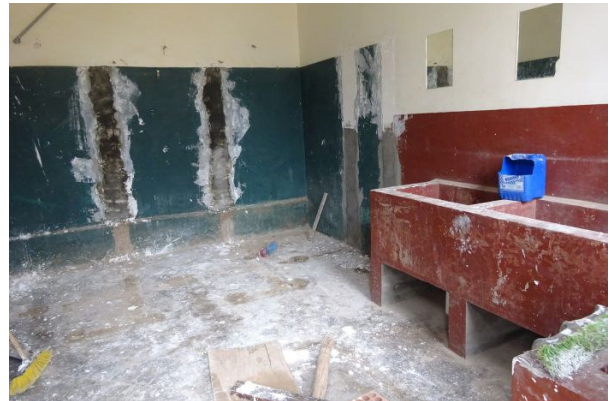
Karipuyo: Renovierung Sanitäranlagen
