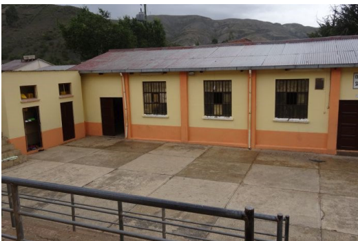
Sakaka: Renovierung Außenfassade
